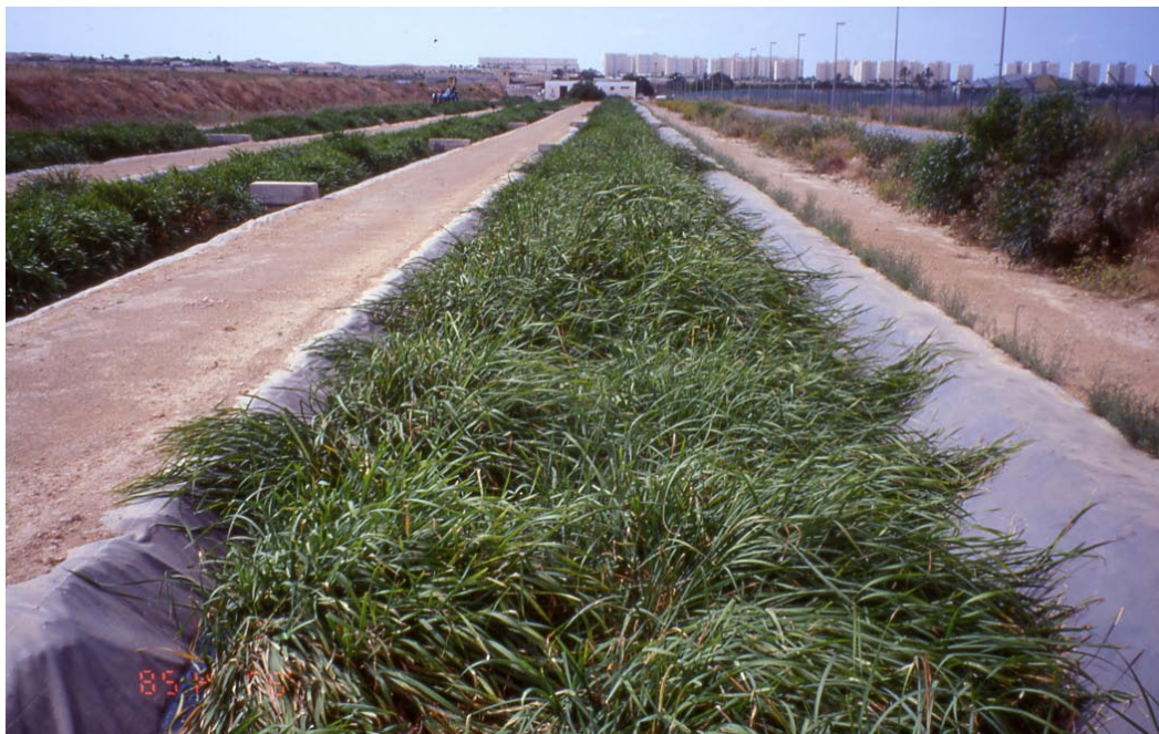
Vista de un canal de depuración con macrofitas en flotación (sistema FMF) en las instalaciones de la depuradora del Aeropuerto de Alicante.
